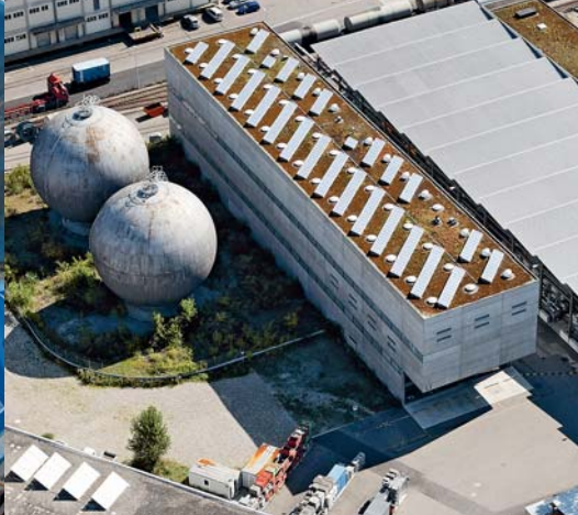
PV-Anlage IWB Zentrallager | Basel ADEV Solarstrom AG 40 kWel | 2005
