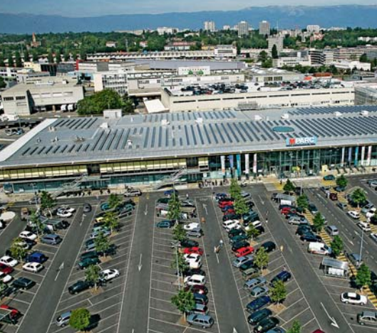
PV-Anlage MParc Carouge | Genf ADEV Solarstrom AG 270 kWel | 2006
