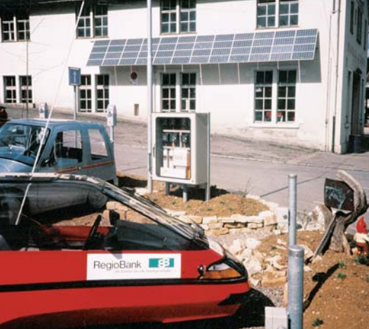
PV-Anlage Parc & Ride | Liestal ADEV Energiegenossenschaft 2 kWel | 1988
