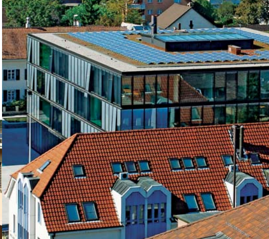
PV-Anlage Gemeindezentrum | Reinach ADEV Solarstrom AG 24 kWel | 2002
