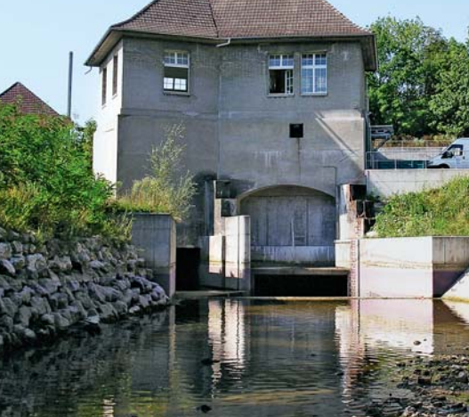
Wasserkraftwerk Untere Emmengasse Luterbach | ADEV Wasserkraftwerk AG 820 kWel | 2000
