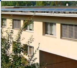
PV-Anlage Hera Kettenacker | Riehen ADEV Solarstrom AG 50 kWel | 2002
