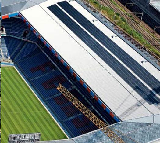
PV-Anlage St. Jakob Stadion | Basel ADEV Solarstrom AG 202 kWel | 2006
