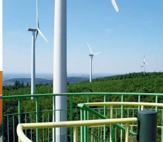
Windanlage im Windpark Ettenheim D ADEV Windkraft AG 1300 kWel | 2000
