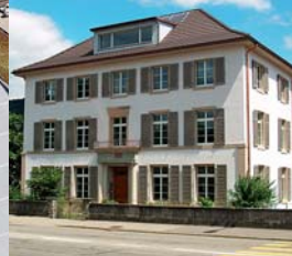
PV-Anlage Kasernenstrasse | Liestal ADEV Solarstrom AG | 1 kWel | 2005
