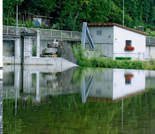
Wasserkraftwerk Gattikonbrücke Langnau | ADEV Wasserkraftwerk AG 150 kWel | 1998
