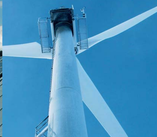
Windanlage Grenchenberg | Grenchen ADEV Windkraft AG | 150 kWel | 1994
