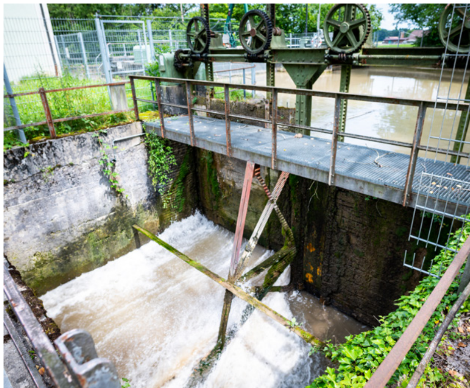
Vor der Sanierung: Die alte Klappe des Kraftwerks Moosbrunnen 1
