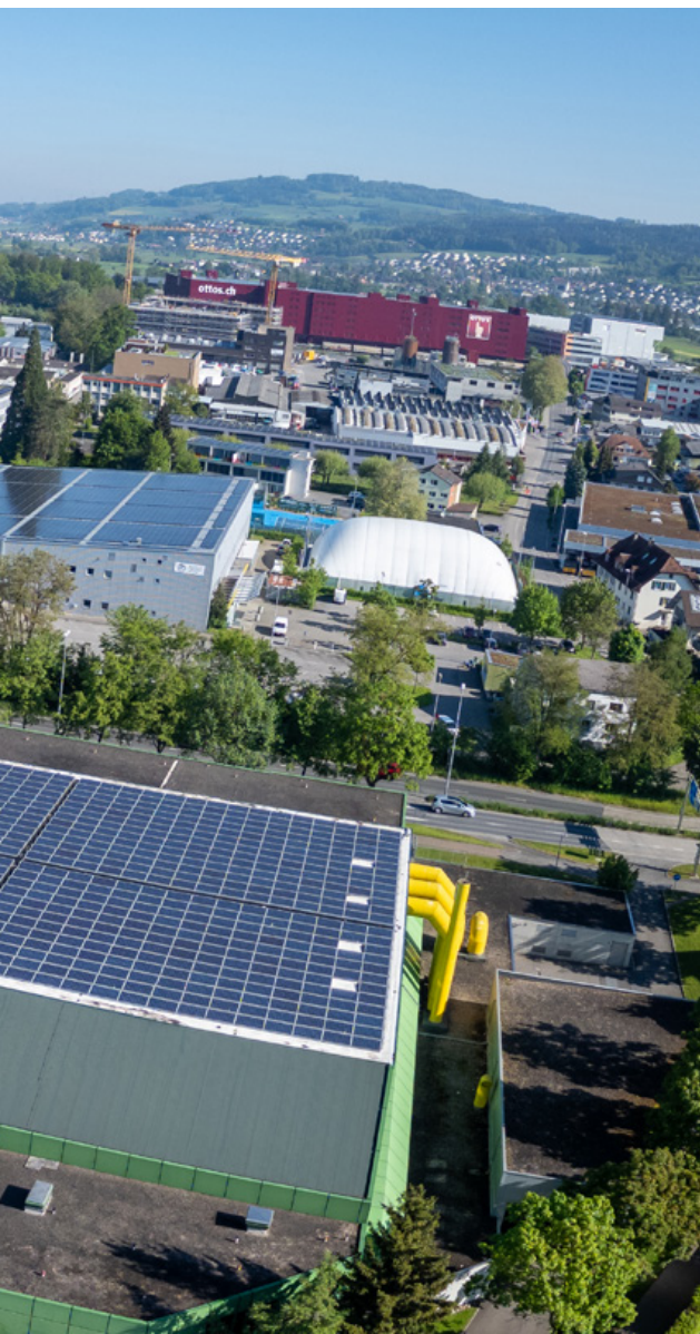
Die drei Anlagen des ZEV auf einen Blick: Stadthalle (vorne rechts), Schulhaus (vorne links) und das Kleinwasserkraftwerk an der Suhre (am Waldrand links neben dem Schulhaus).
