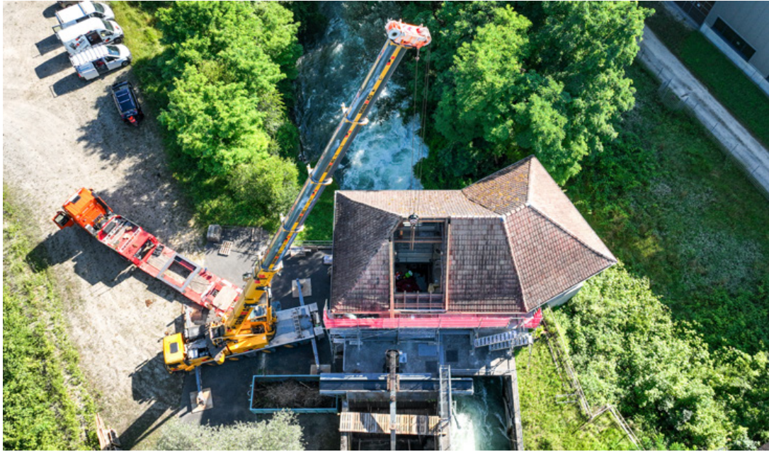
Um die Turbine aus dem Gebäude zu heben, musste ein Teil des Daches des Kraftwerks Untere Emmengasse abgebaut werden.
