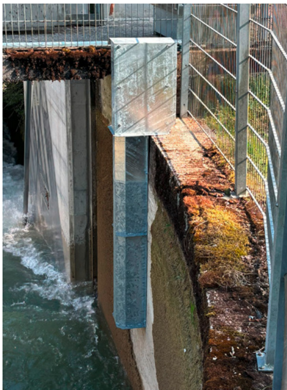
In diesem Stahlgehäuse befindet sich der Schwimmer, der sich bei hohem Wasserstand automatisch hebt.
