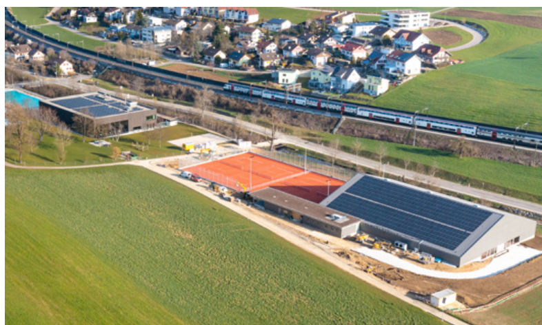
Beispiel Gelterkinden: Zukünftig könnten nicht nur das Bad und die Tennishalle, sondern auch umliegende Quartiere von Solarstrom profitieren.
