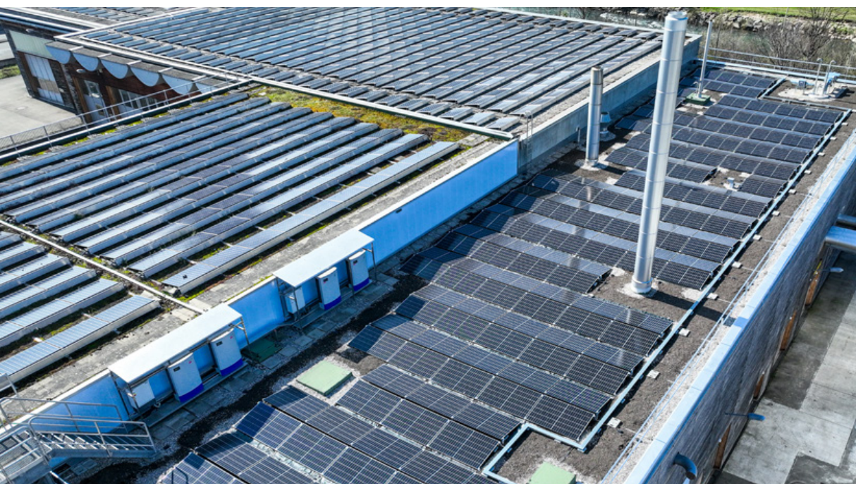
Die Installateure bauten die neue Anlage (im vorderen Bildteil) um die Kamine herum.
