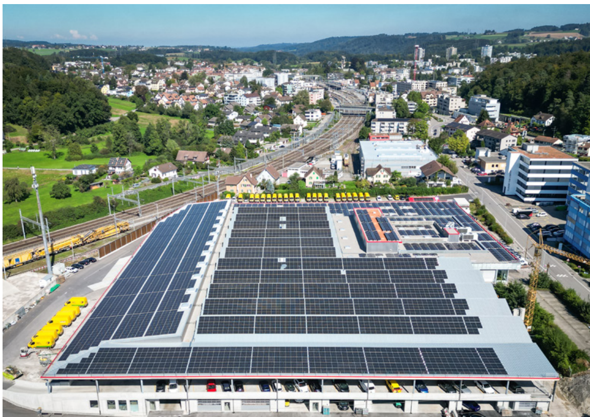
Une vue aérienne permet de bien se rendre compte de la taille impressionnante de l'installation.
