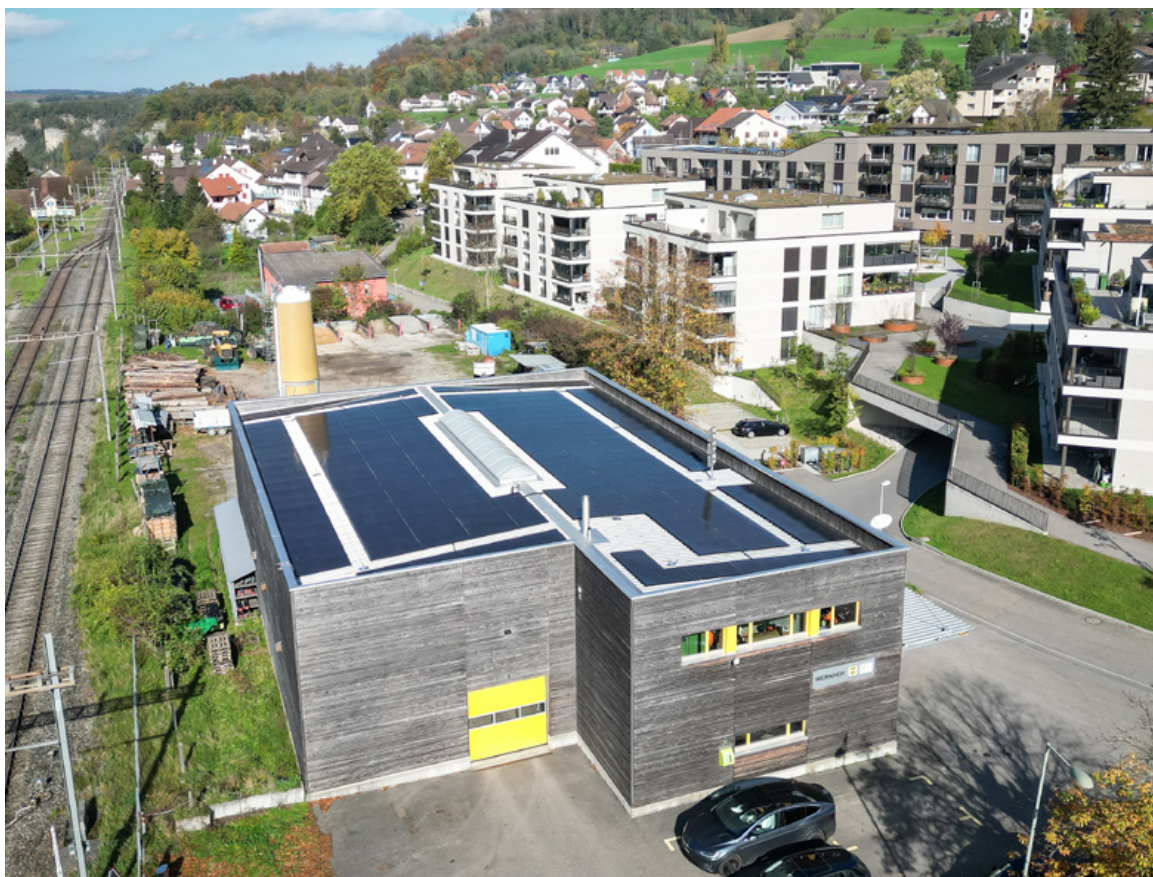
Le bâtiment de la voirie de Läuelfingen avec, au premier plan, les places de stationnement pour la recharge des véhicules électriques.
