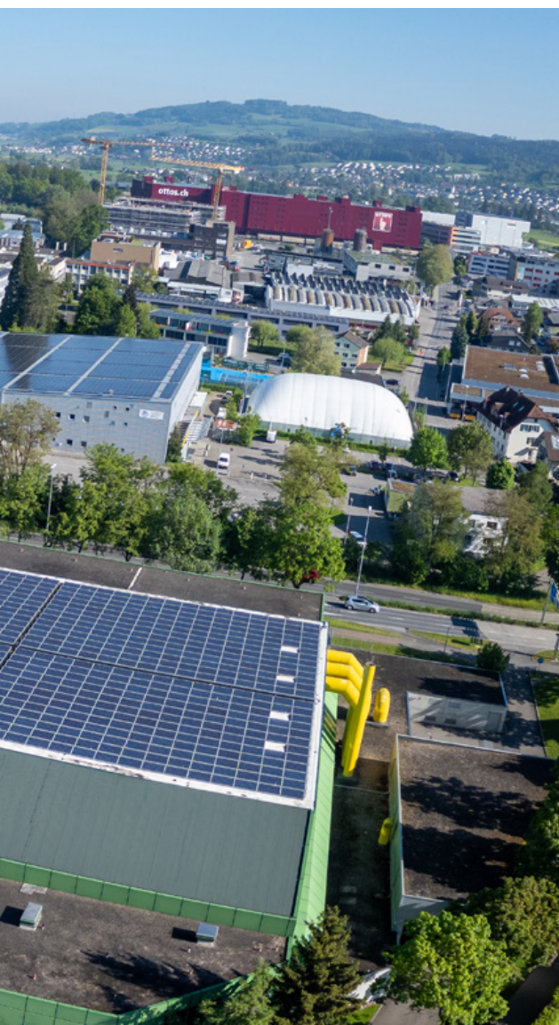
Vue d'ensemble des trois installations du RCP, avec la salle polyvalente (au premier plan, à droite), la nouvelle école (au premier plan, à gauche) et la petite centrale hydroélectrique sur la Suhre (en bordure de forêt, à gauche de l'école).
