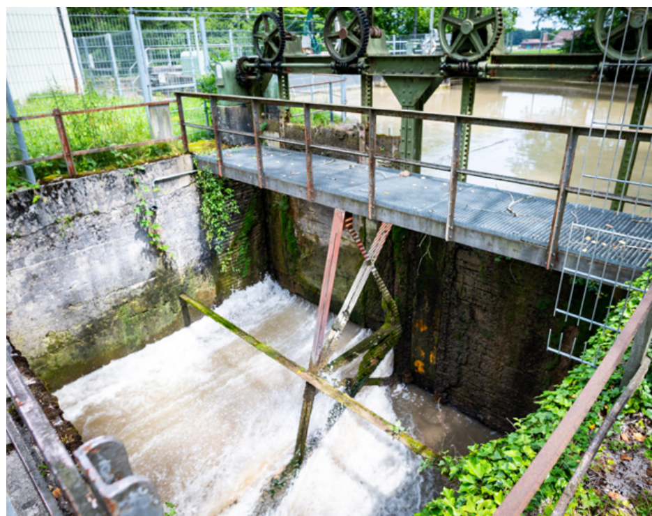
Avant la rénovation : l'ancien clapet de la centrale de Moosbrunnen 1.
