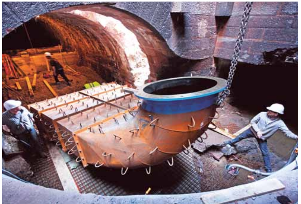
Bauarbeiten am Kraftwerk Hammer, das komplett neu gebaut wurde. Hier wird das Saugrohr eingebaut.
