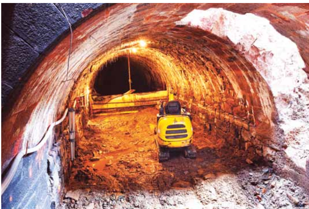
Der alte, 1832 gebaute Kanal des Kraftwerks Hammer, in den das Saugrohr eingebaut werden musste.
