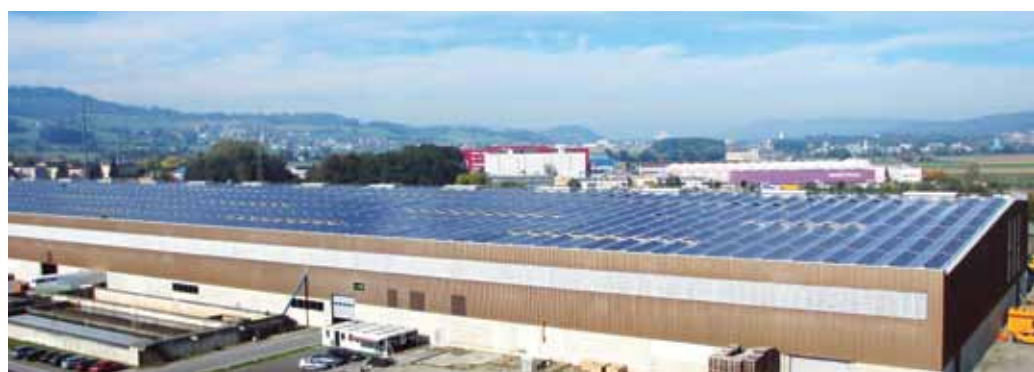
In gut drei Monaten gebaut, die 2.9 MW-Anlage Ferrowohlen.
