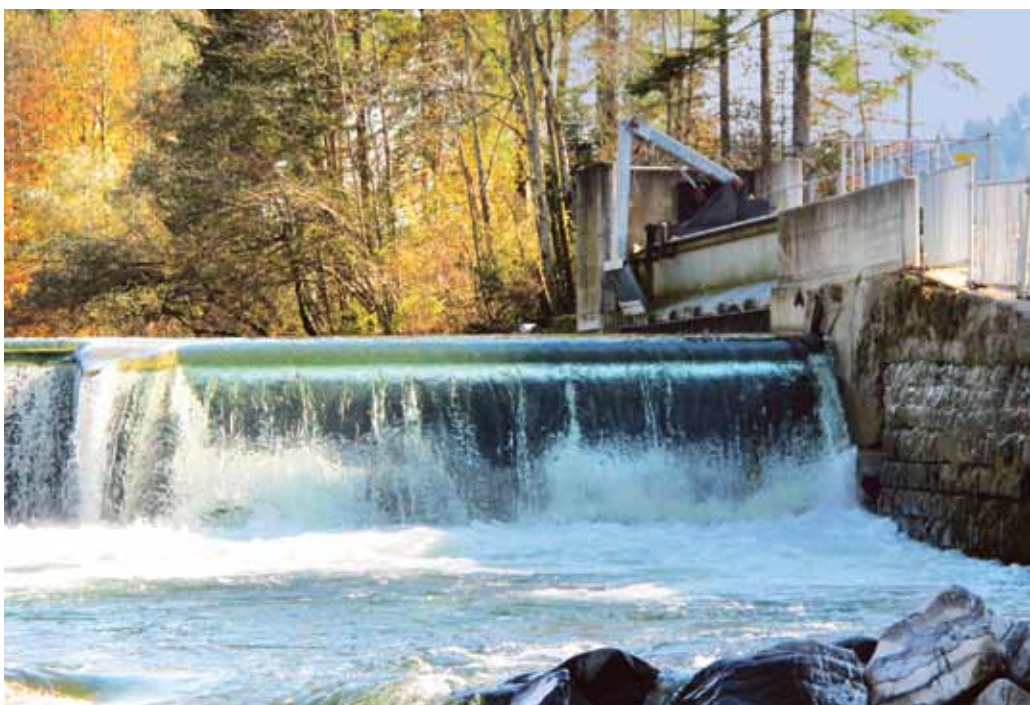
Das neue Kraftwerk Emmenau 2 produziert 30 % mehr Strom als das alte.
