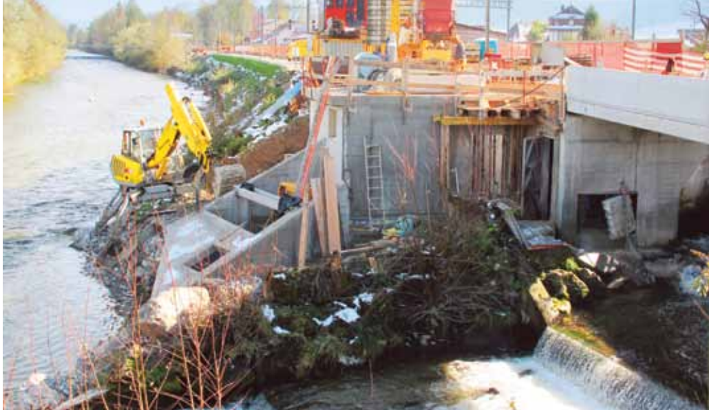
Bau am Kraftwerk Emmenau 2, das komplett neu gebaut wurde.
