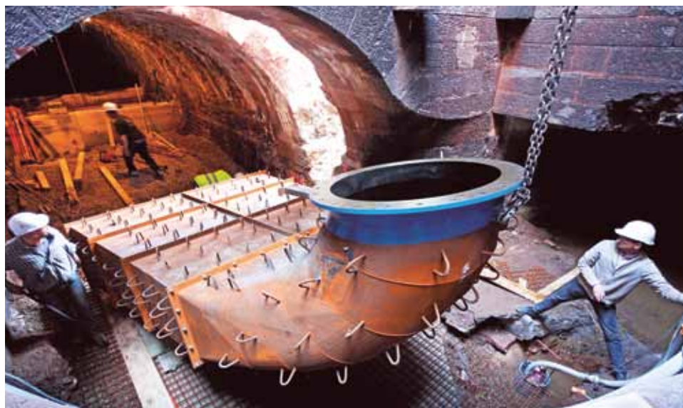
Le chantier de la centrale hydroélectrique de Hammer, qui a dû être complètement reconstruite. Ici, la pose du tuyau d'aspiration.
