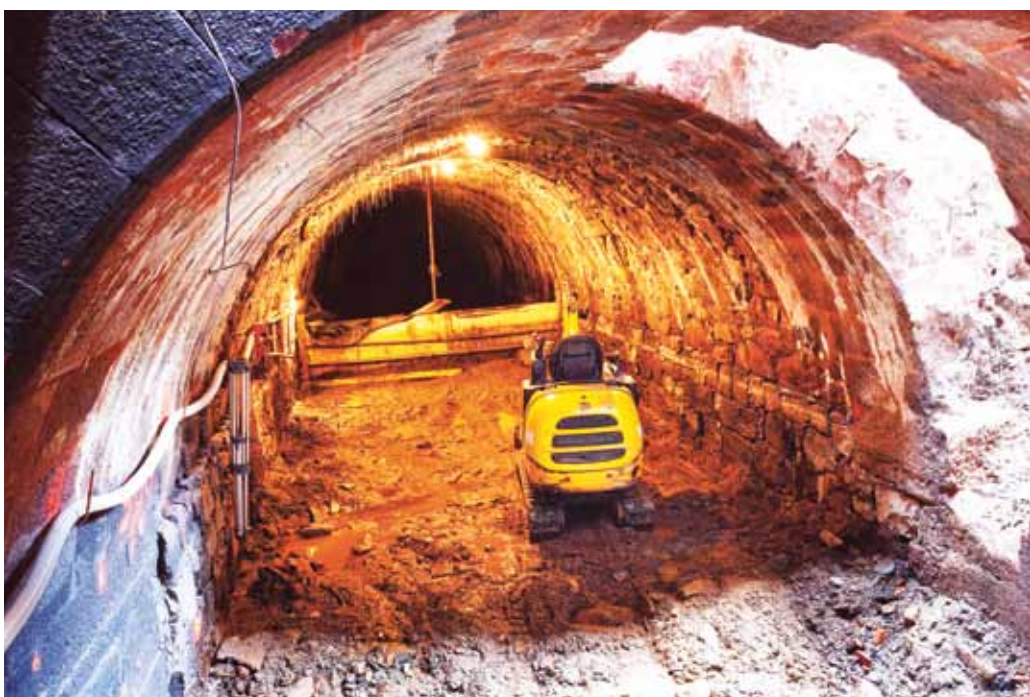
L'ancien canal de la centrale de Hammer, datant de 1832, dans lequel le tuyau d'aspiration a été aménagé.
