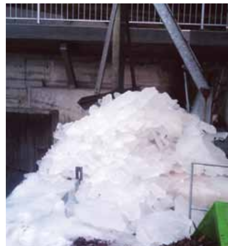
Winterbetrieb Wasserkraftwerk Gattikonbrücke
