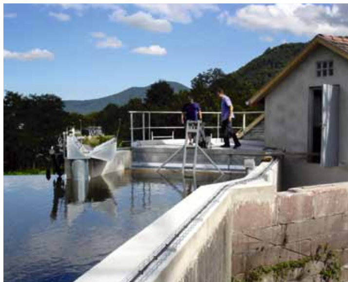
Das sanierte Kraftwerk Hammer
