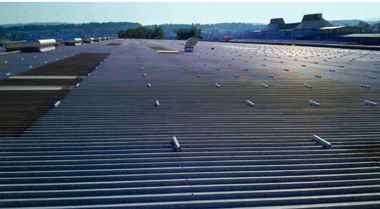
Die Arbeiten auf dem Dach sind voll im Gange, Ende September geht die Anlage ans Netz.
