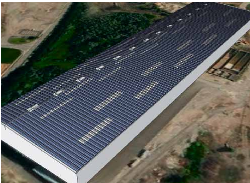
Das Dach der Stahlwerkhalle misst 320 auf 80 Meter, 11 840 Photovoltaikmodule werden darauf installiert.
