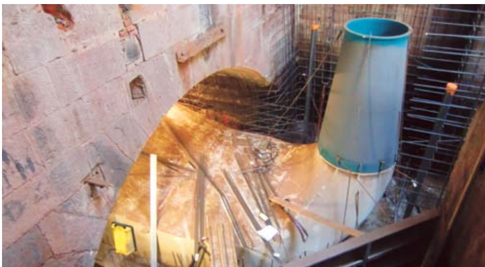
Einbau Saugrohr im unterirdischen alten Kanal unter der Fabrikhalle.
