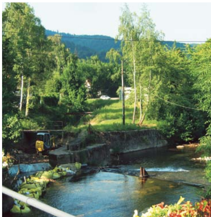
Sanierung der Wasserentnahme an der Fecht.
