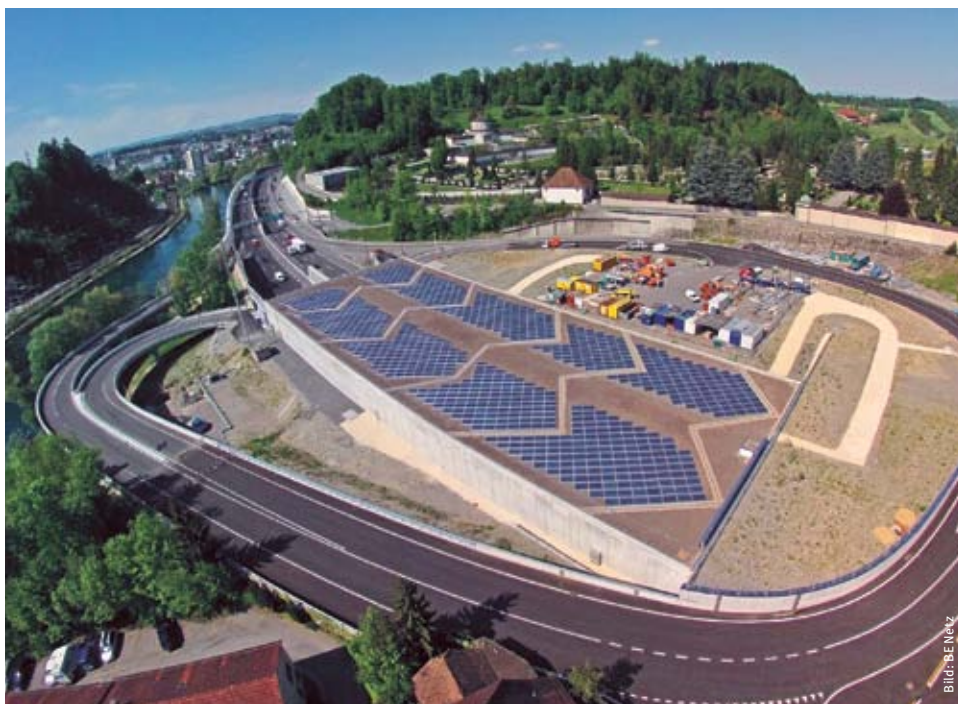
Die Anlage Reussport, eine von vielen Möglichkeiten, Solarstromanlagen auf bebauten Flächen zu integrieren.
