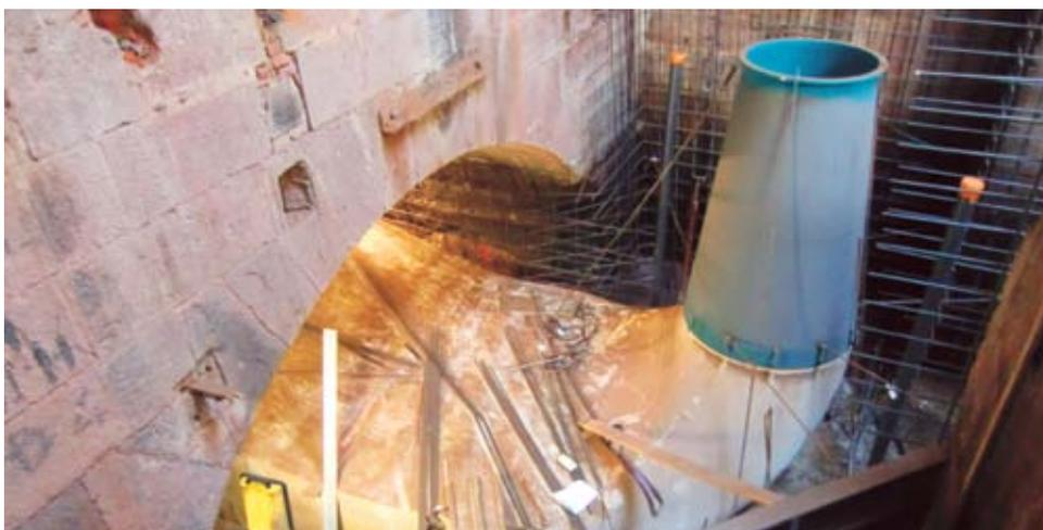
Montage du tuyau d'aspiration dans l'ancien canal souterrain sous l'atelier de production.
