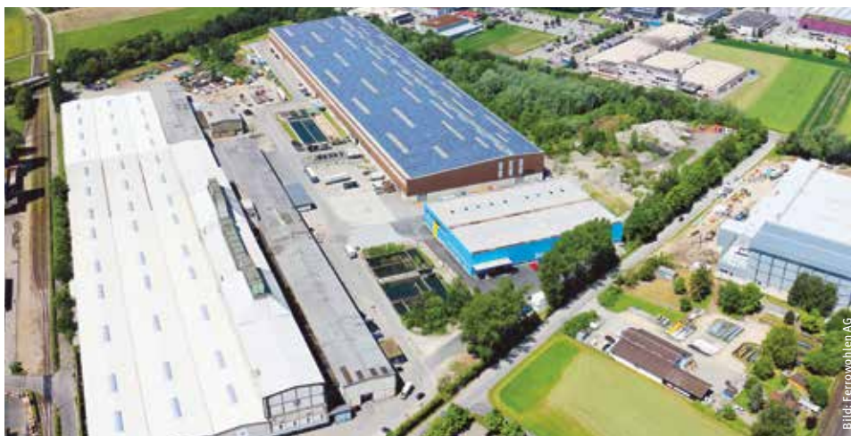
Die 2.9 MW-Solarstromanlage Ferrowohlen produzierte fast einen Drittel der gesamten Solarstromproduktion.
