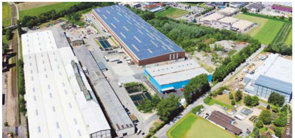
L'installation de Ferrowohlen et ses 2,9 MW de puissance ont assuré près du tiers de la production totale de courant solaire.
