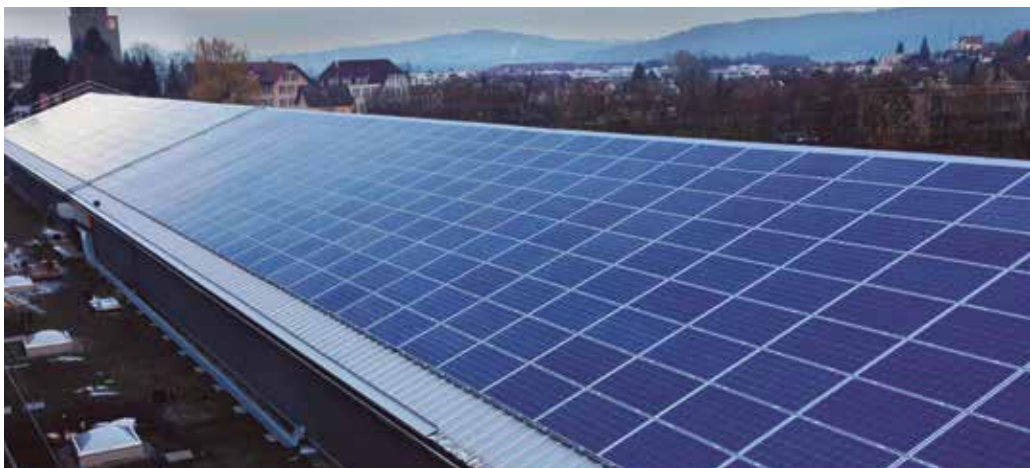
Non loin de la centrale solaire de Ferrowohlen (voir p. 1), ADEV Solarstrom AG a pu réaliser une installation solaire de 1 MW sur le toit de l'entreprise Xaver Meier AG.
