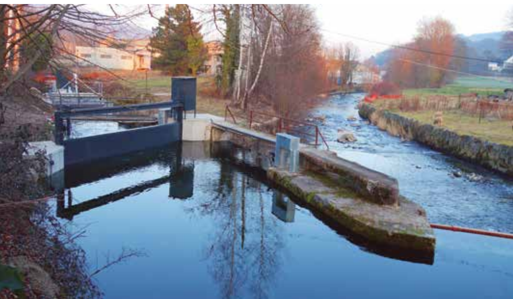
L'eau de la Fecht est captée par le canal qui alimente la centrale électrique du Couvent.
