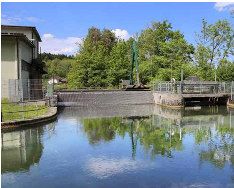
Das Kraftwerk Moosbrunnen 1, das die ADEV Mitte 2014 kauft, produziert jährlich 2.6 Mio. Kilowattstunden Wasserstrom.
