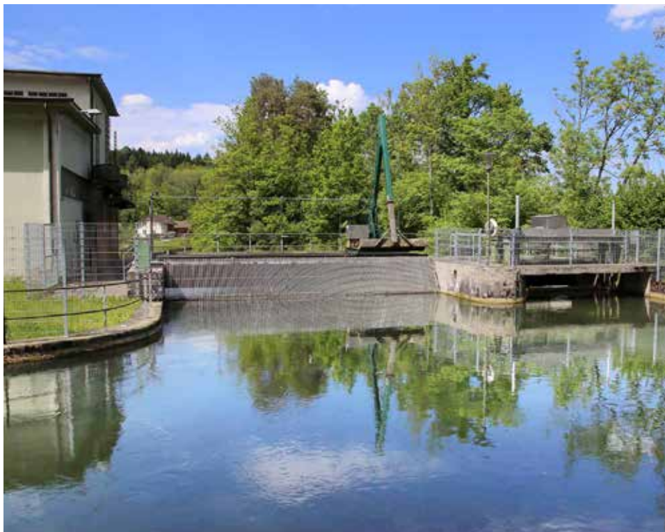
La centrale de Moosbrunnen 1, qu'ADEV achètera à l'été 2014, produit annuellement 2,6 millions de kWh d'hydroélectricité.
