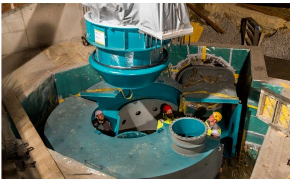
Die Turbine wird mit dem Pneukran ins Kraftwerk gehisst.
