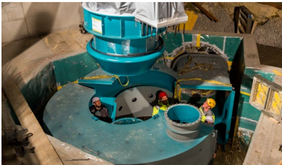
La turbine a été hissée au moyen d'une grue pneumatique.
