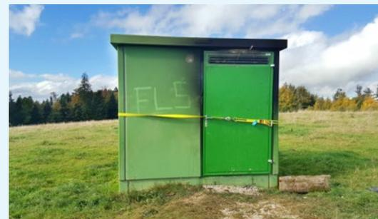
Beschädigte Schaltanlage in St. Brais. Als Brandursache wird Brandstiftung vermutet.
