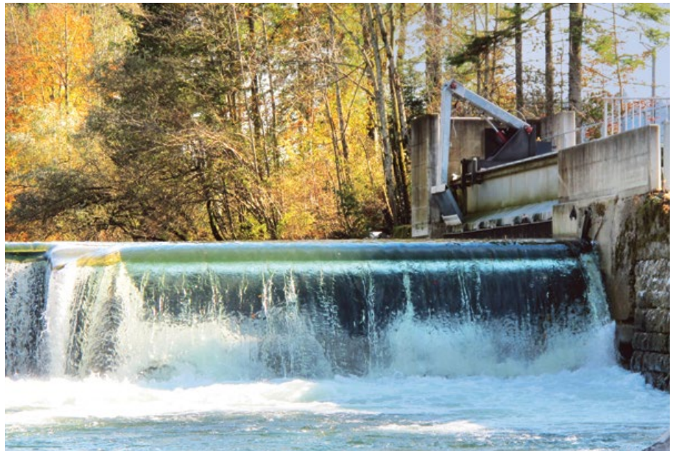
Auf das schlechte Wasserkraftjahr 2015 folgte ein knapp unterdurchschnittliches Wasserstromjahr 2016.
