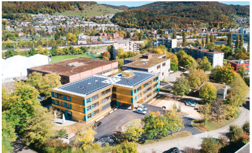
Auf dem kommunalen Primarschulhaus Frenkenbündten der Stadt Liestal wurde eine 80 kW-Anlage realisiert. Der Strom wird direkt vor Ort verbraucht. Abnehmer sind auch die angrenzenden kantonalen Gebäude, die keine Solarstromanlagen haben.
