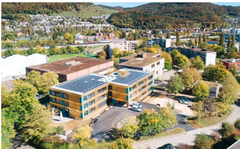
Une installation de 80 kW a été réalisée sur l'école communale Frenkenbündten à Liestal. L'électricité est consommée sur place et dans des bâtiments de l'administration cantonale situés à proximité.
