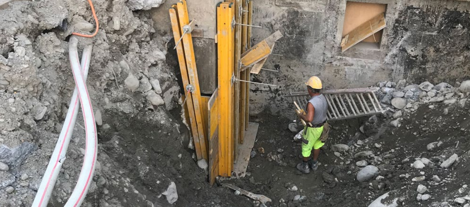
Les travaux dans la cour de récréation : c'est là qu'on a construit le silo à copeaux de bois.
