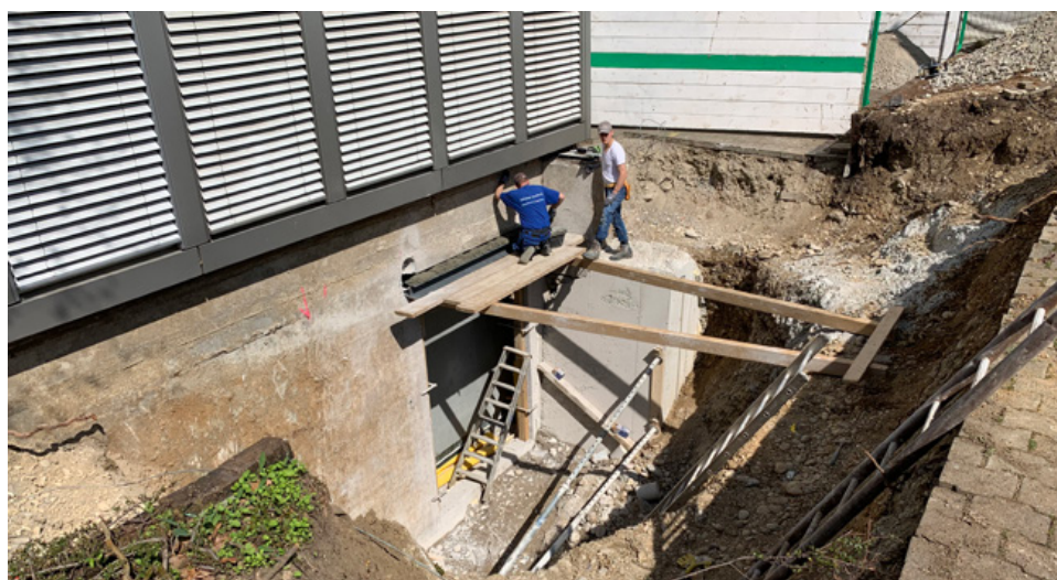
Les préparatifs pour le nouveau chauffage à copeaux de bois.
