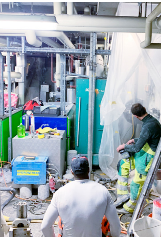
Démontage de la centrale de chauffage fonctionnant au mazout.
