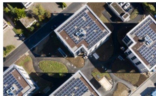
Zusammenschluss zum Eigenverbrauch Bodmen in Reinach. Für die Planung und Betriebsführung zeichnet die ADEV.
