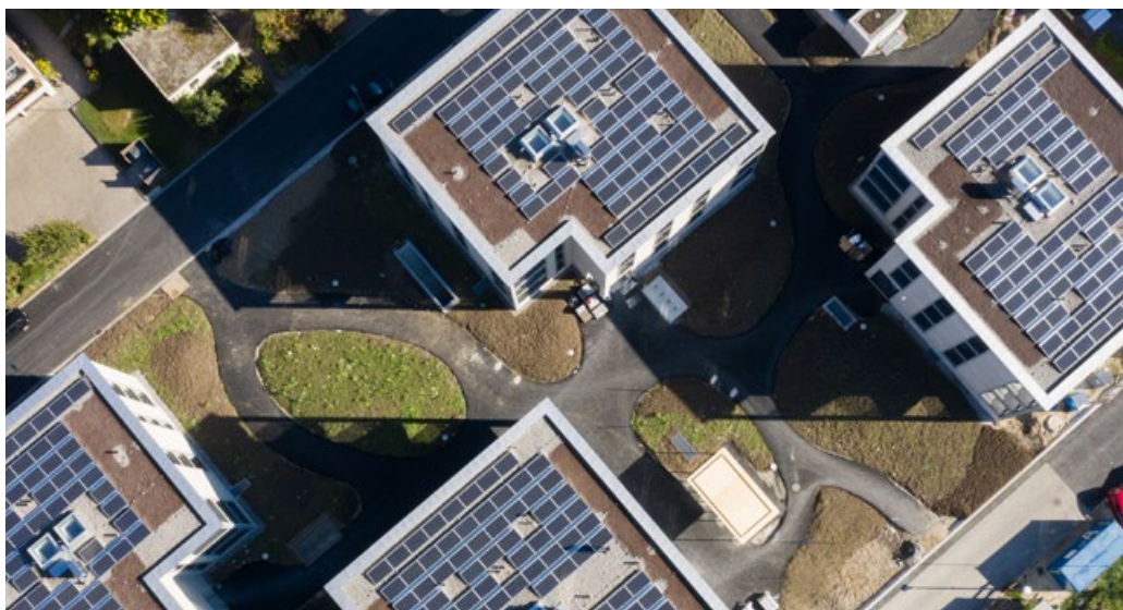
Connexion avec la communauté de consommation propre Bodmen à Reinach. ADEV a conçu l'installation et la gère.
