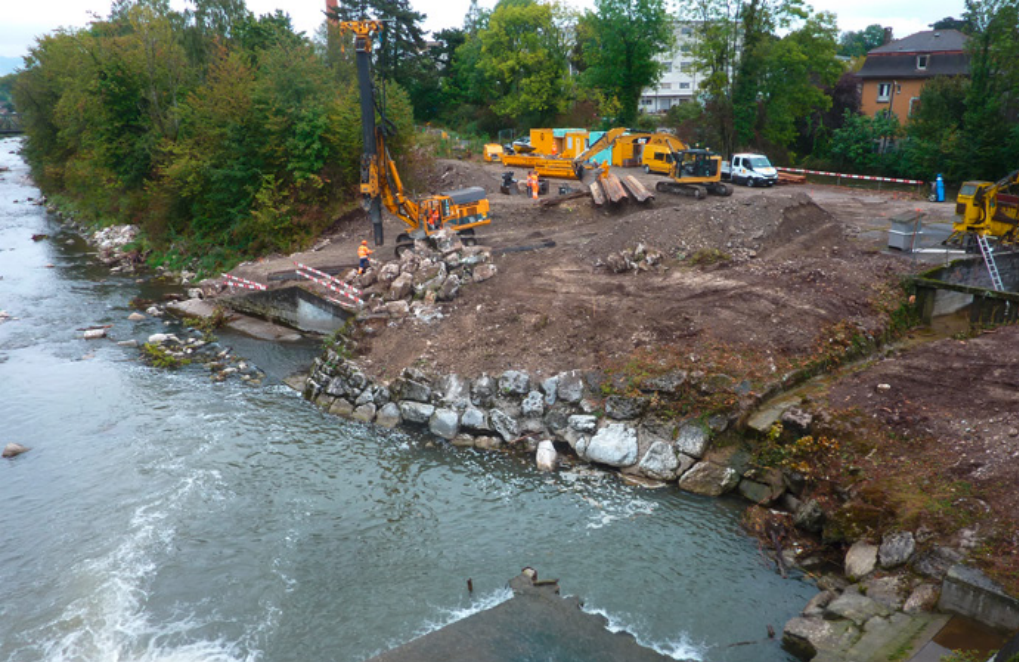
Links die Bauarbeiten auf dem Dach der Ferrowohlen AG, rechts die vom Bund verordneten und finanzierten Arbeiten an der Emme bei Biberist.
