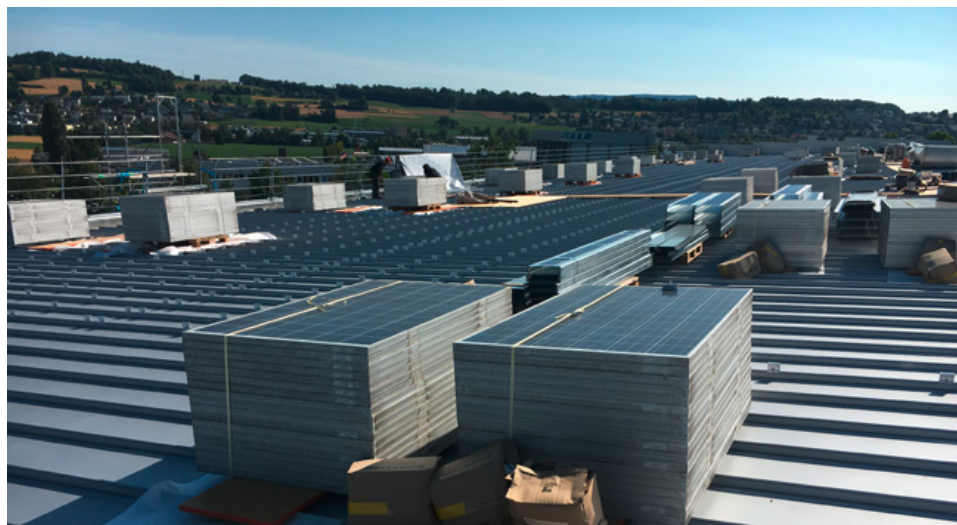
Die Solarstrommodule müssen auf dem neu gedämmten Dach wieder montiert werden.
