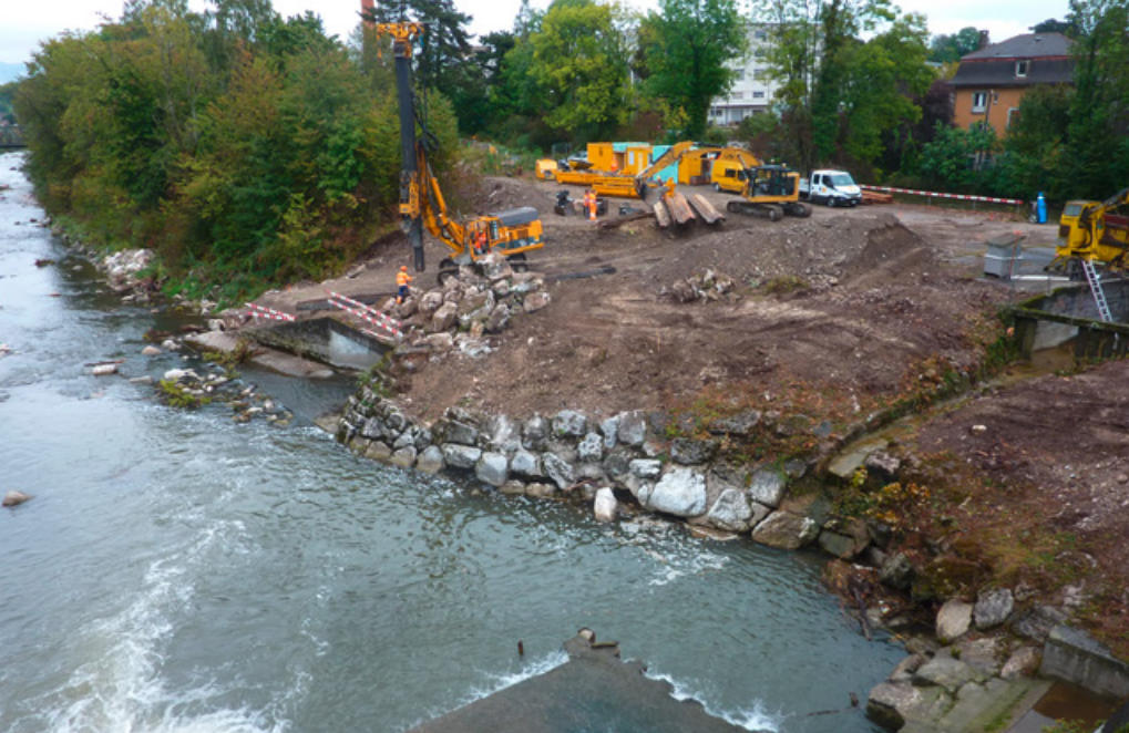
À gauche les travaux de construction sur le toit de Ferrowohlen AG, à droite les travaux sur l'Emme près de Biberist, commandés et financés par la Confédération.
