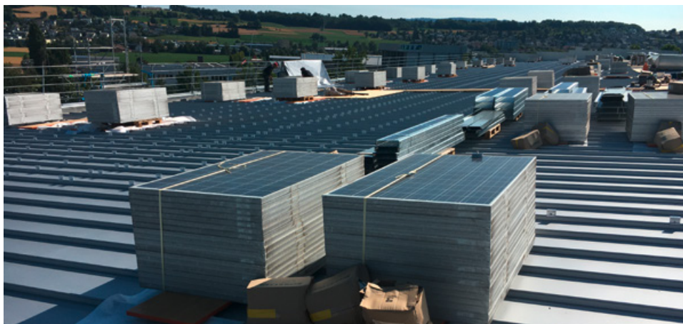
Les modules solaires doivent être reposés sur le toit nouvellement isolé.
