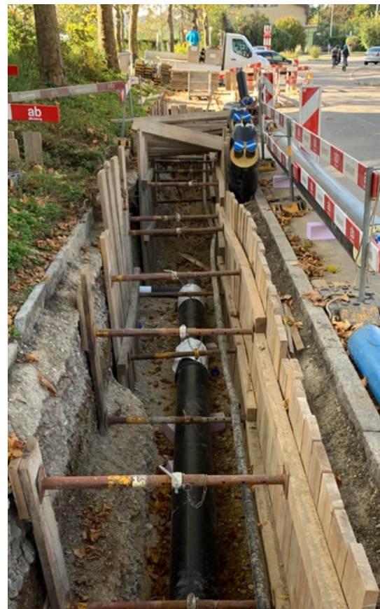
Die Gräben waren schon ausgehoben, als noch zwei Wohnblocks dazukamen
