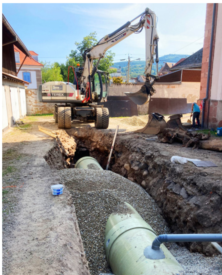
Das korrodierte Eisenrohr wurde durch ein modernes GFK-Rohr ersetzt.
