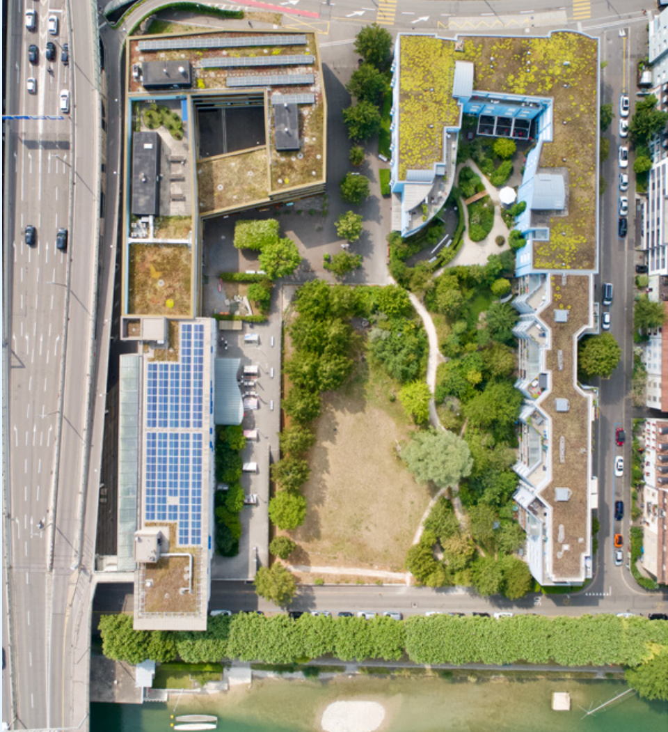
Das Blockheizkraftwerk im Alterszentrum Alban-Breite liefert nicht nur Wärme, sondern auch rund 450 Megawattstunden Strom pro Jahr.
