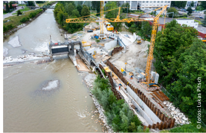
Travaux sur le déversoir de l'Emme à Biberist
