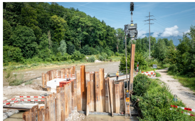
Le chantier de la centrale Moosbrunnen 3 à Gerlafingen
