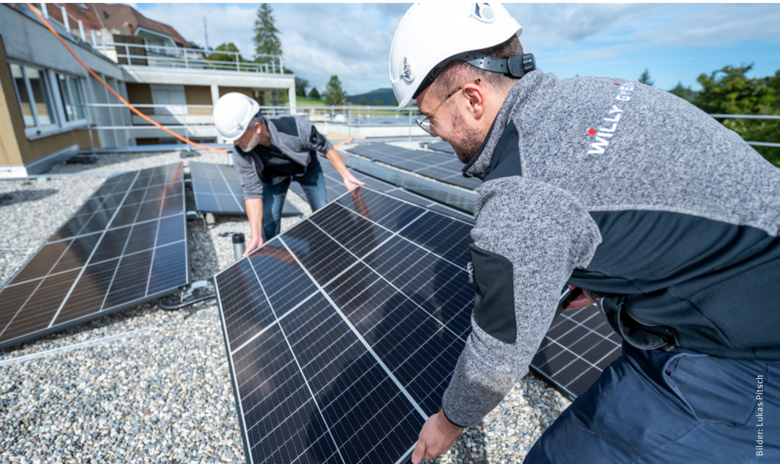
Monteure der Willy Gysin AG verbauen die neuen Module fachgerecht.
