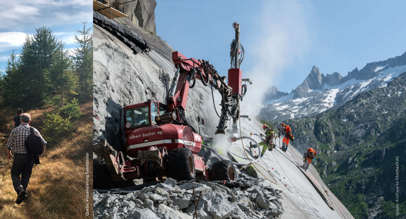
Die Staumauer des Grimselsees wird derzeit saniert. Schon bald könnte sie um 23 Meter aufgestockt werden.
