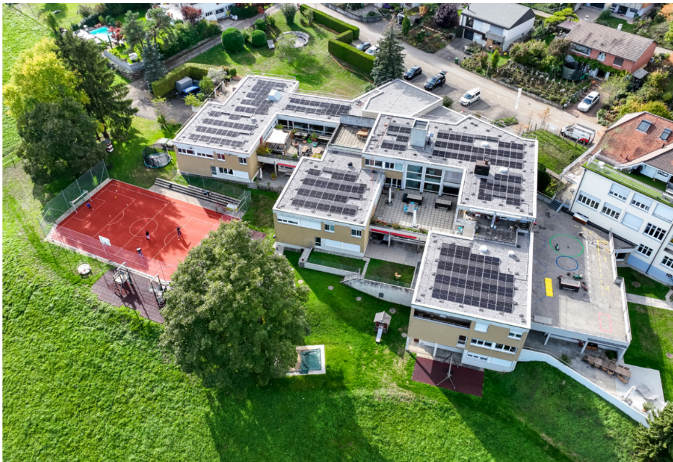
Die Flachdächer eignen sich hervorragend für eine Ost-West-Anlage.
