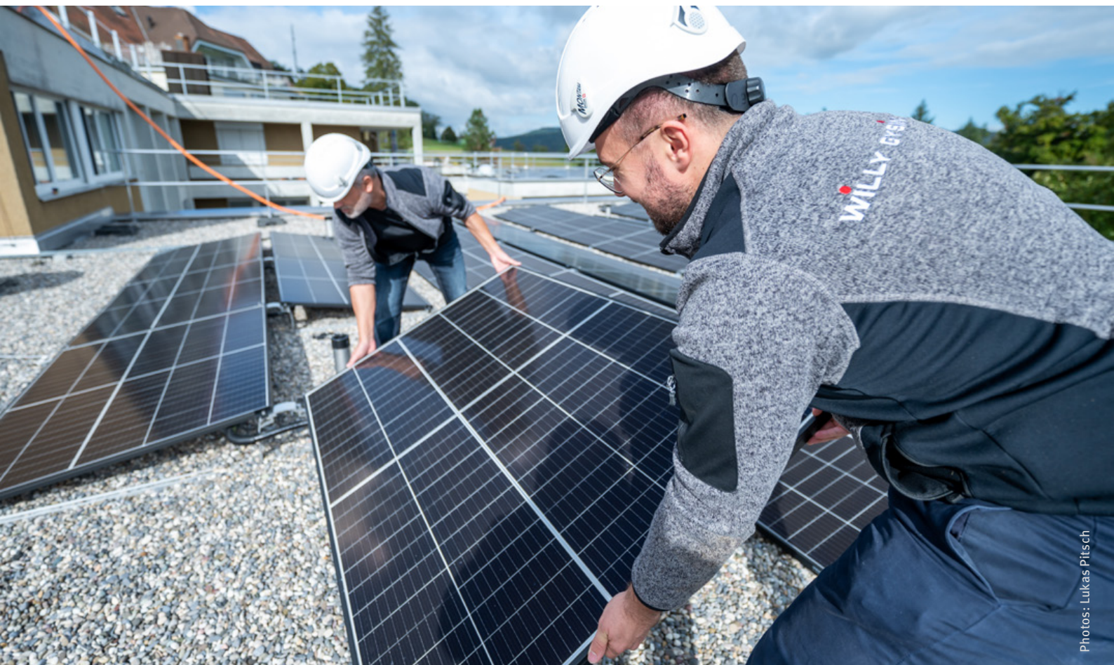
Les monteurs de Willy Gysin AG installent les nouveaux modules.
