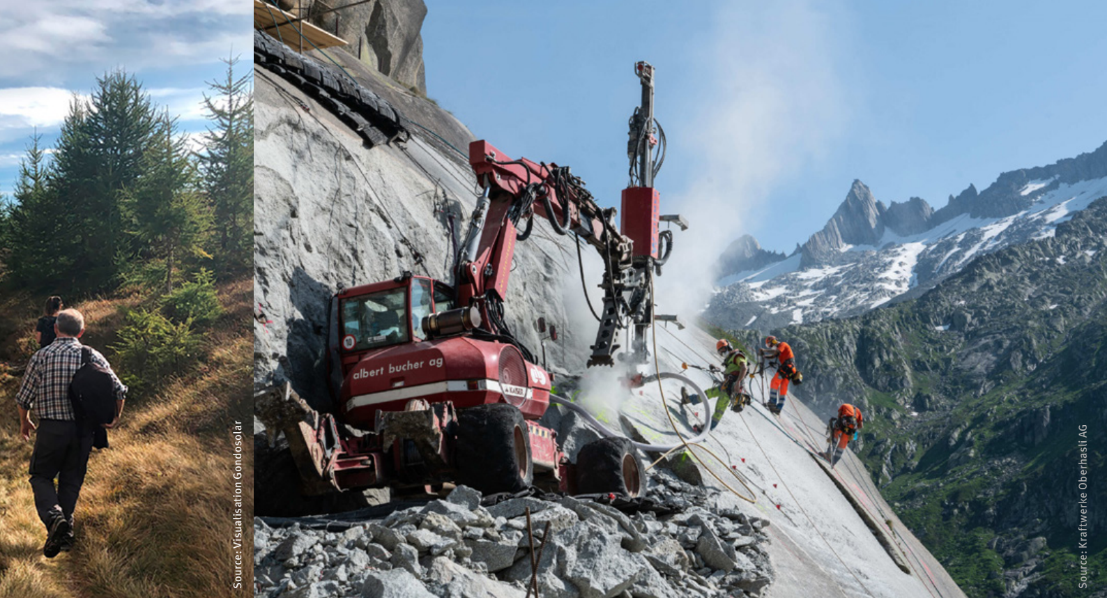
Le barrage du Grimsel est en cours de rénovation. Il pourrait bientôt être rehaussé de 23 m.
