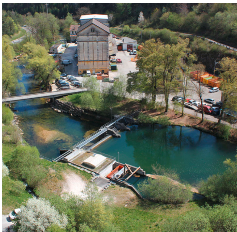
Das Kraftwerk am Ortsausgang südlich von Laufen.
