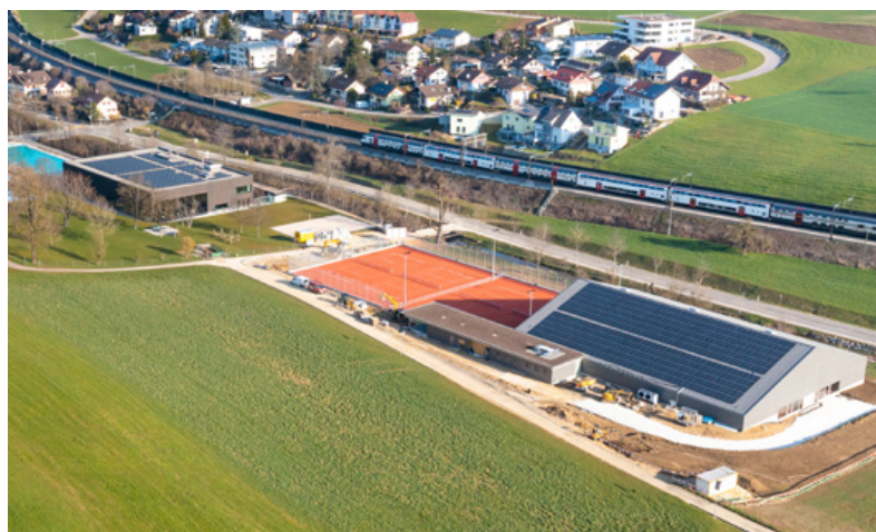
L'exemple de Getterkinderen : à l'avenir, l'électricité solaire produite sur les toits de la piscine et de la halle de tennis pourrait aussi approvisionner les quartiers voisins.
